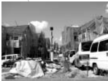
←建設中の ドリームハウス旭ヶ丘
